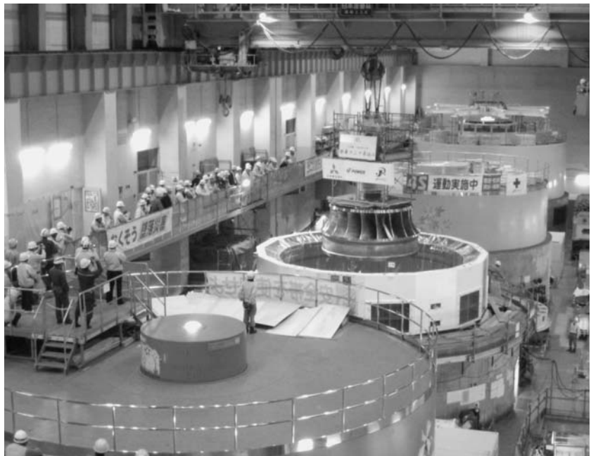
水車と発電機の一 体更新で出力を向 上（Jパワー田子 倉発電所）
