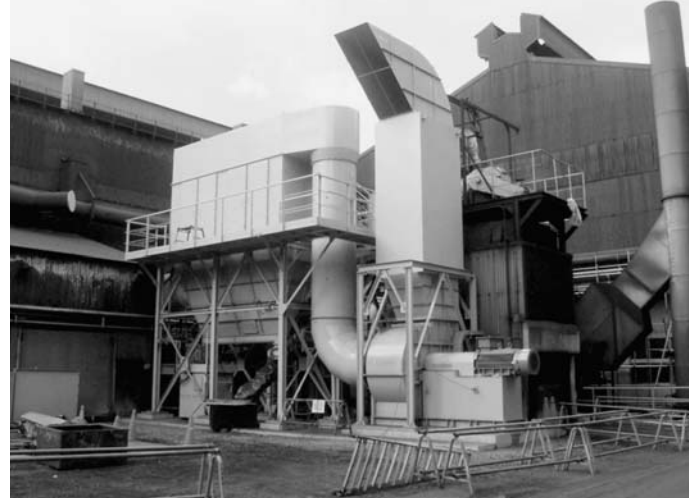
製鋼工場に設置している集塵機 (流機エンジニアリング提供)
