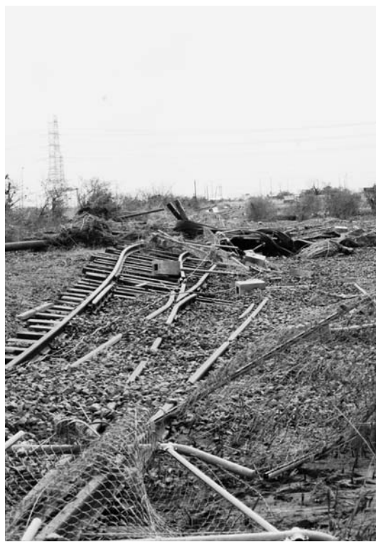
鹿島港北公共埠頭近くの線路が津波で崩壊した
