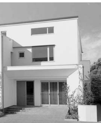
床・壁・屋根が一体となったモノコック構造のツーバイフォー工法は、高い耐震性を誇る（三井ホームのツーバイフォー住宅）
