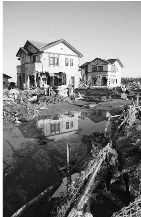
津波により多くの家屋が流された(花巻市)
