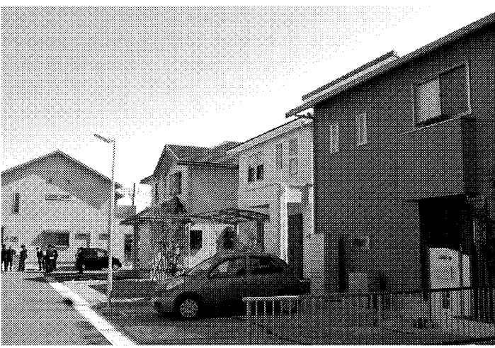
11年2月に完成した静岡ガスの「エコライフスクエア三島さすみ」
